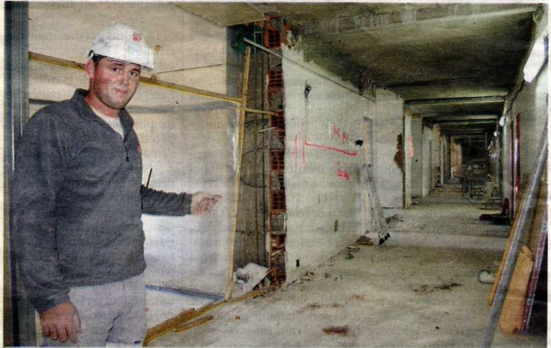
Hier, les ouvriers d'Eiffage continuaient leur travail de sappe dans les étages du bâtiment médico-chirurgical de l'hôpital afin de préparer l'arrivée des 55 lits de la clinique. © PIERRE-OLIVIER JULIEN
